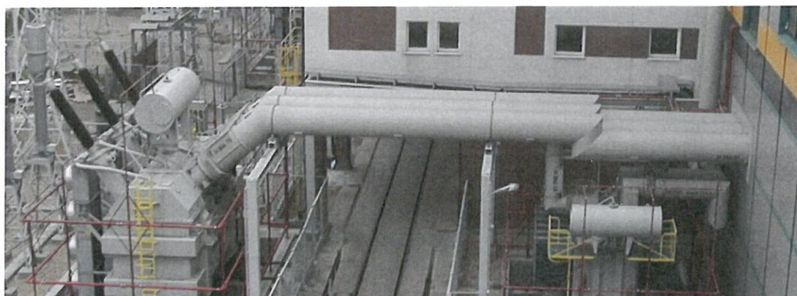
Rys. 1.2. Jednobiegunowy trójfazowy GIL [4]
