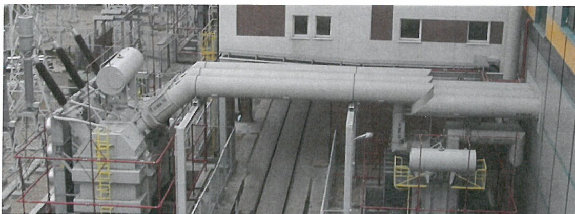
Rys. 1.2. Jednobiegunowy trójfazowy GIL [4]
